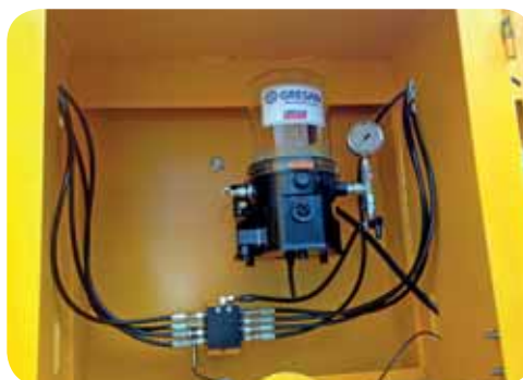
AUTOMATIC LUBRICATION WITH SENSORS SYSTEME DE LUBRIFICATION AUTOMATIQUE A CAPTEUR
